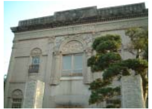
正面上にHOSPITAL TUCHDAと家紋が掘ってある。
